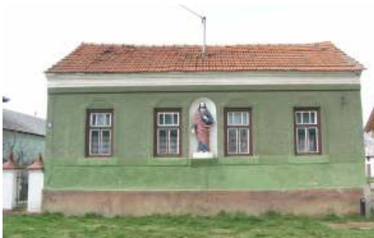
Slika 24 Stambena kuća na k.br. 58. u Gardinovcu
