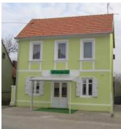
Slika 18 Obnovljena tradicijska građevina stambene i javne namjene (krčma) na k.br. 126. u ulici K. Tomislava u Belici
